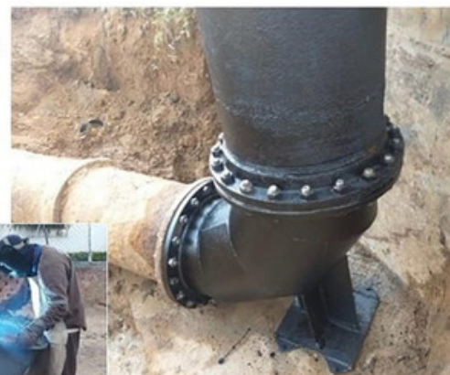
SAA Maceió – Casal – Cia. de Saneamento de Alagoas Rompimento de Tubulação DN 500mm de Reservatório Elevado Fabricação: 36 horas | Montagem: 12 horas Água Tratada | Maceió / AL | 07/05/2019
