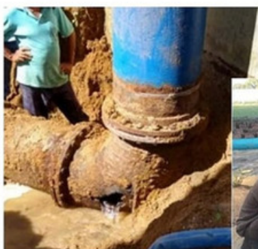
SAA Maceió – Casal – Cia. de Saneamento de Alagoas Rompimento de Tubulação DN 500mm de Reservatório Elevado Fabricação: 36 horas | Montagem: 12 horas Água Tratada | Maceió / AL | 07/05/2019
