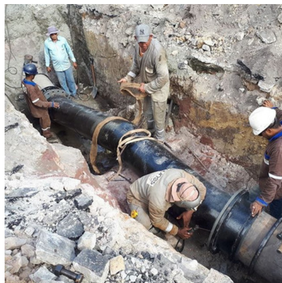
Interligação na Adutora de Recalque DN 500mm
