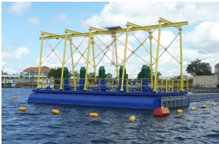
Captação Flutuante fabricada em aço carbono, Rio Xingu, Altamira, Pará
