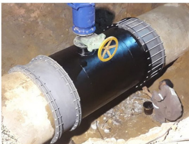
Sistema Monjope - Compesa Rompimento de Adutora Concreto DN 1100mm Água Bruta Abreu e Lima / PE 01/05/2019
