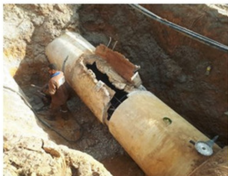
Sistema Monjope - Compesa Rompimento de Adutora Concreto DN 1100mm Água Bruta Abreu e Lima / PE 01/05/2019
