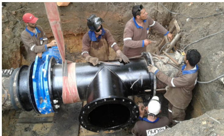
Interligação Alimentação do Poço de Sucção
