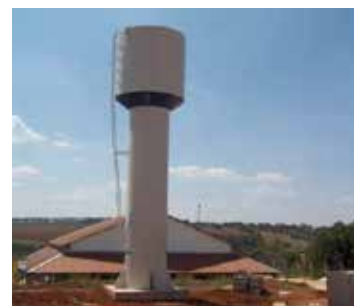
Reservatórios Tipo Taça
