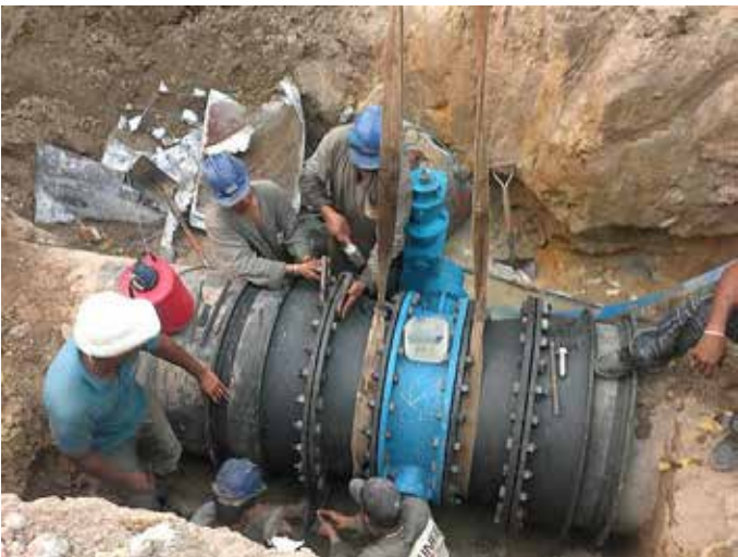
Instalação de válvula borboleta DN 800mm, adutora de concreto DN 1000mm, Sistema Alto do Céu, Recife | PE. Cliente: Cia. Pernambucana de Saneamento - Compesa
