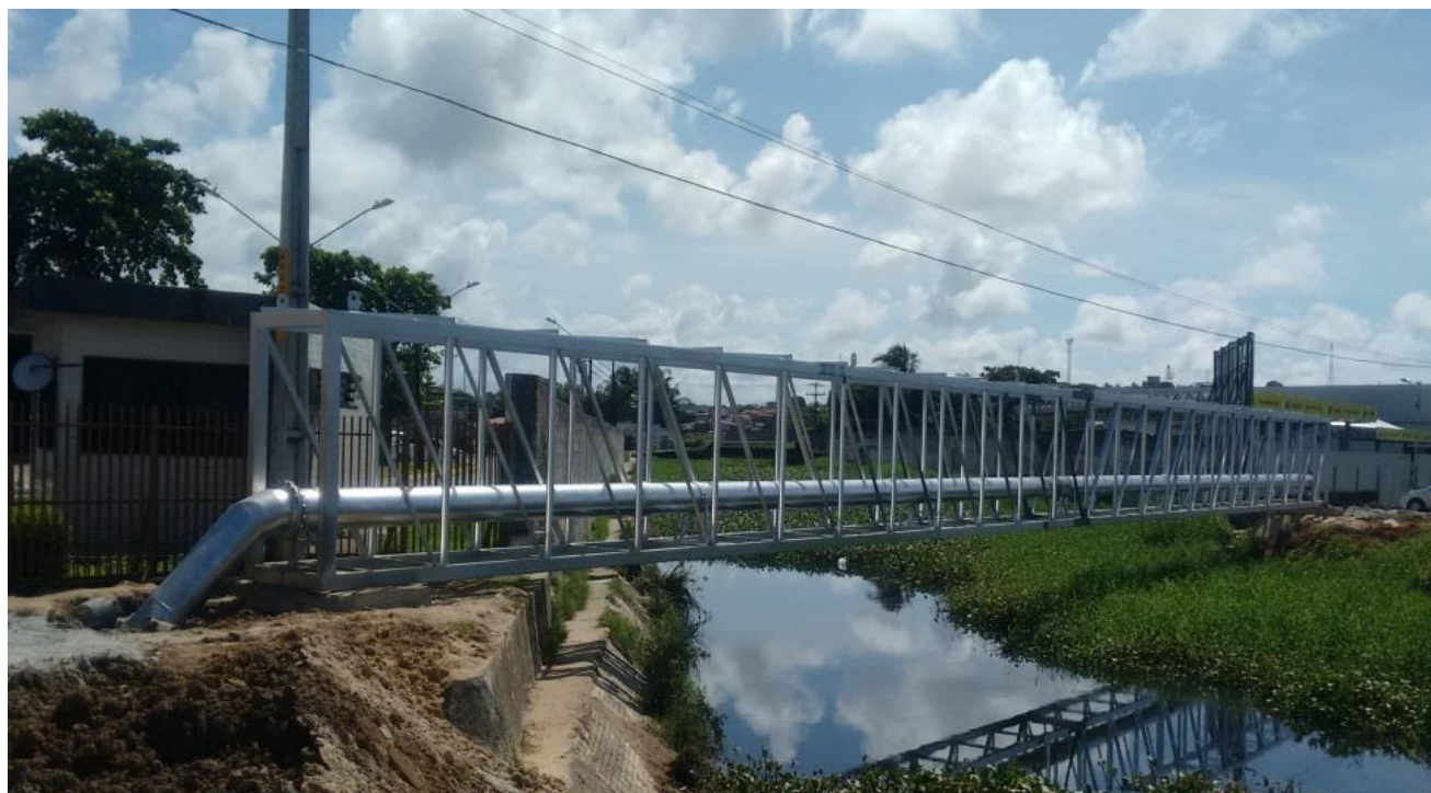
Travessia DN 400mm provida de Estrutura Trelçada
