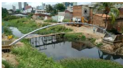
Travessia em Arco DN 150mm
