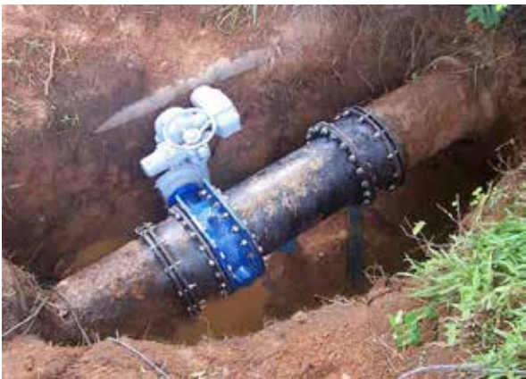
Instalação de válvula borboleta DN 400mm, linha de recalque da ETA Alto do Céu, Recife | PE. Cliente: Cia. Pernambucana de Saneamento - Compesa
